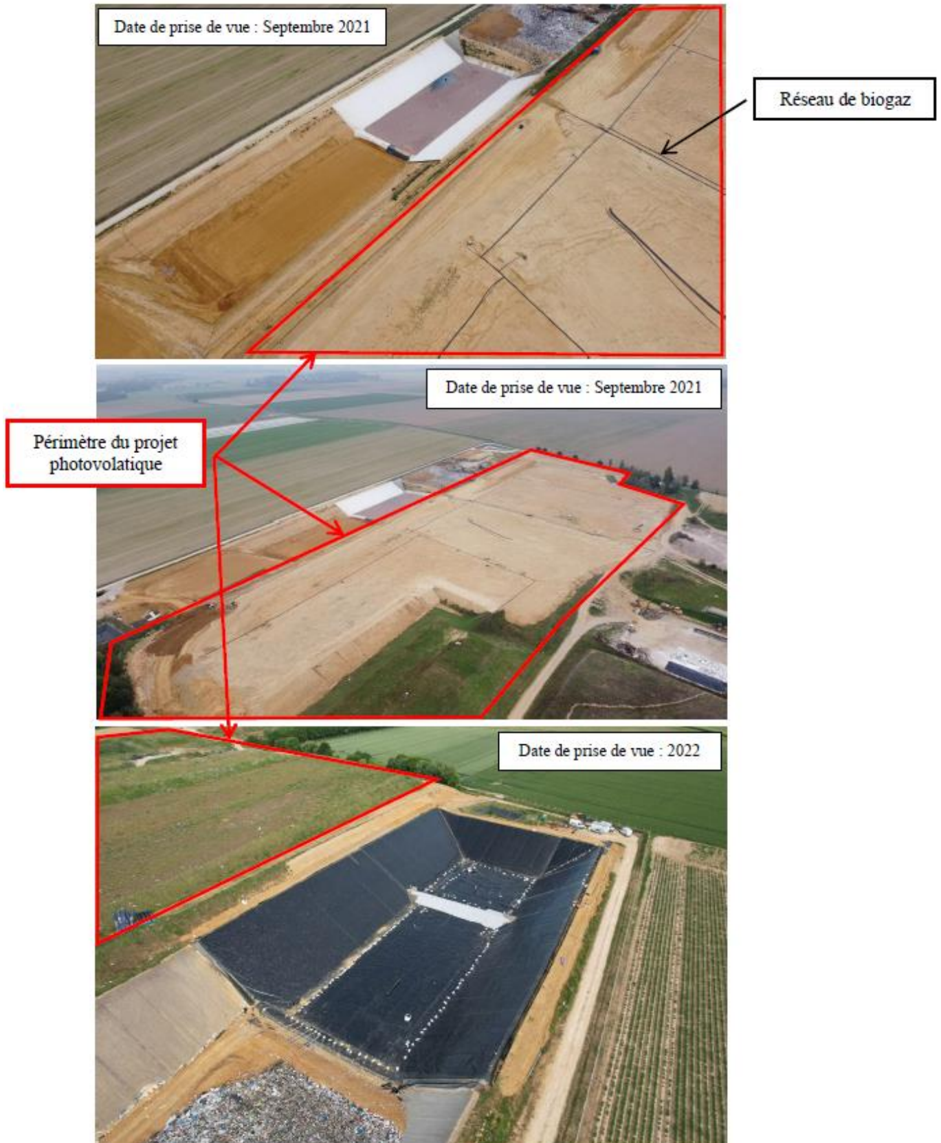
Illustration n° 4 : Images aériennes du CETRAVAL (Source : SDOMODE)
